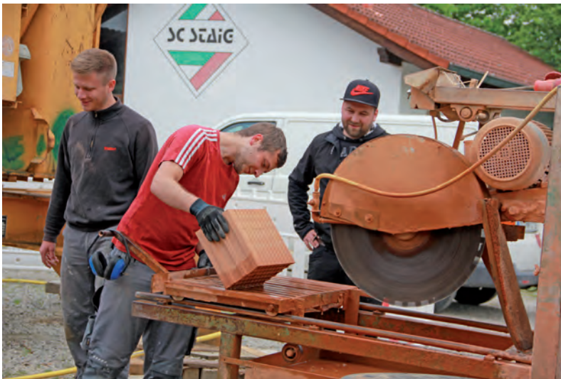
Etliche Stunden wurden bereits durch Eigenleistungen am Rohbau erbracht, u.a. auch die Herstellung der Zwischenmauern
