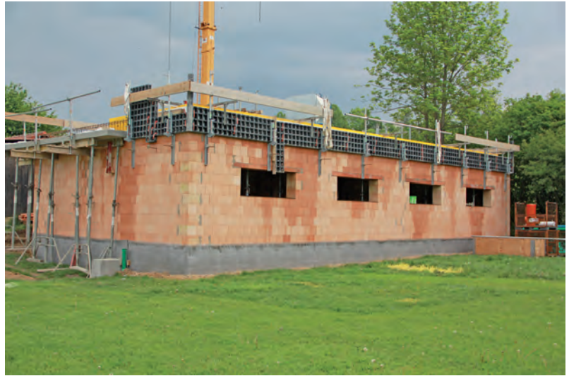
Die Rohbauarbeiten sind mittlerweile abgeschlossen
