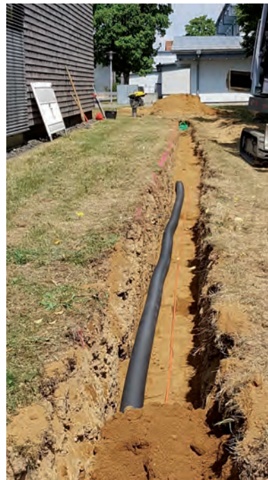
70 Meter Glasfaserkabel und Leerrohre haben unsere Helfer verlegt
